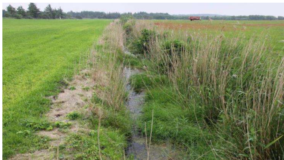
Figur 22: Sydfra kommende grøft i afvandingssystem 21 set fra den sydlige projektgrænse mod syd.
